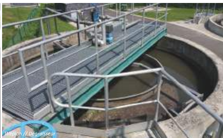
Mornimont // Sables récupérés en conteneur de l'unité de dessablage
