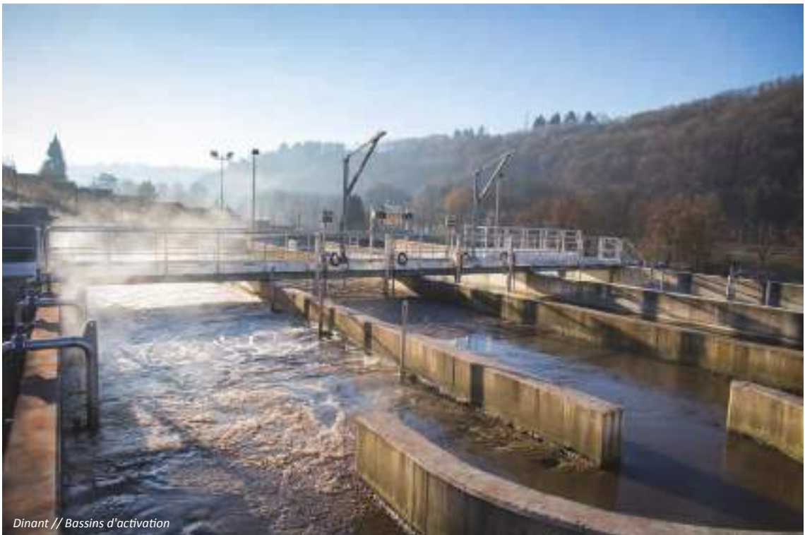
Floreffe // Nettoyage de la goulotte du clarificateur
