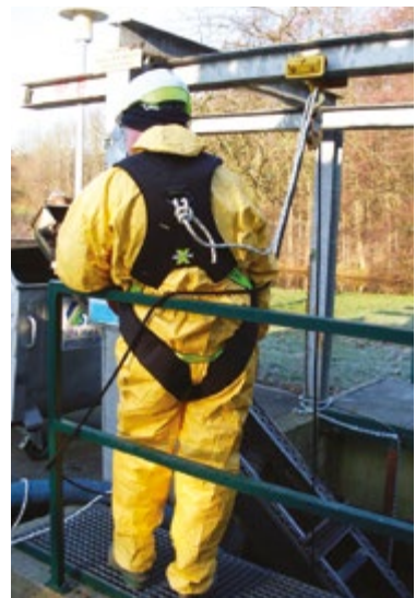
Équipement de protection individuelle portés par nos agents lors de leur descente dans les ouvrages d'épuration
