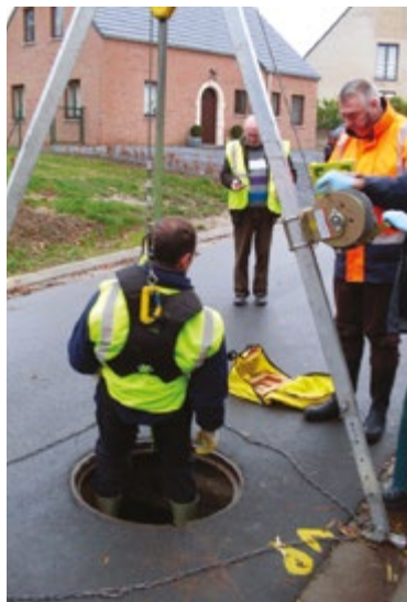
Accès dans une chambre de visite sans échelle
