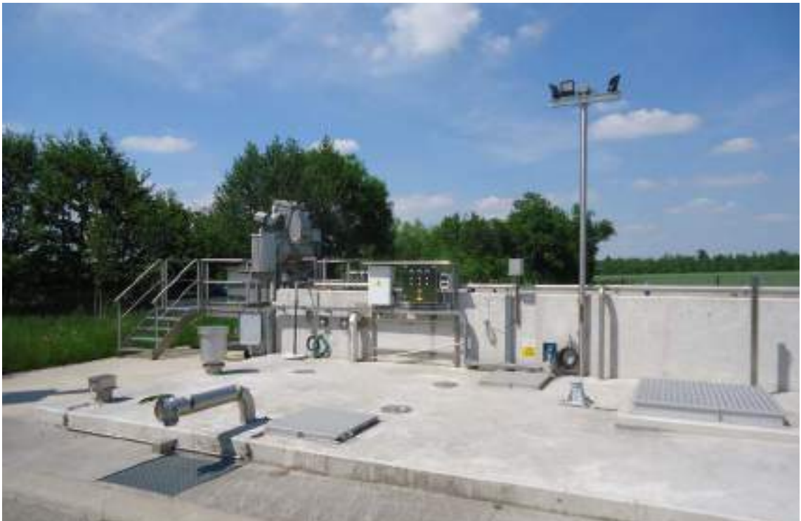
Pontillas Gochenée // Nouvelle station d'épuration
