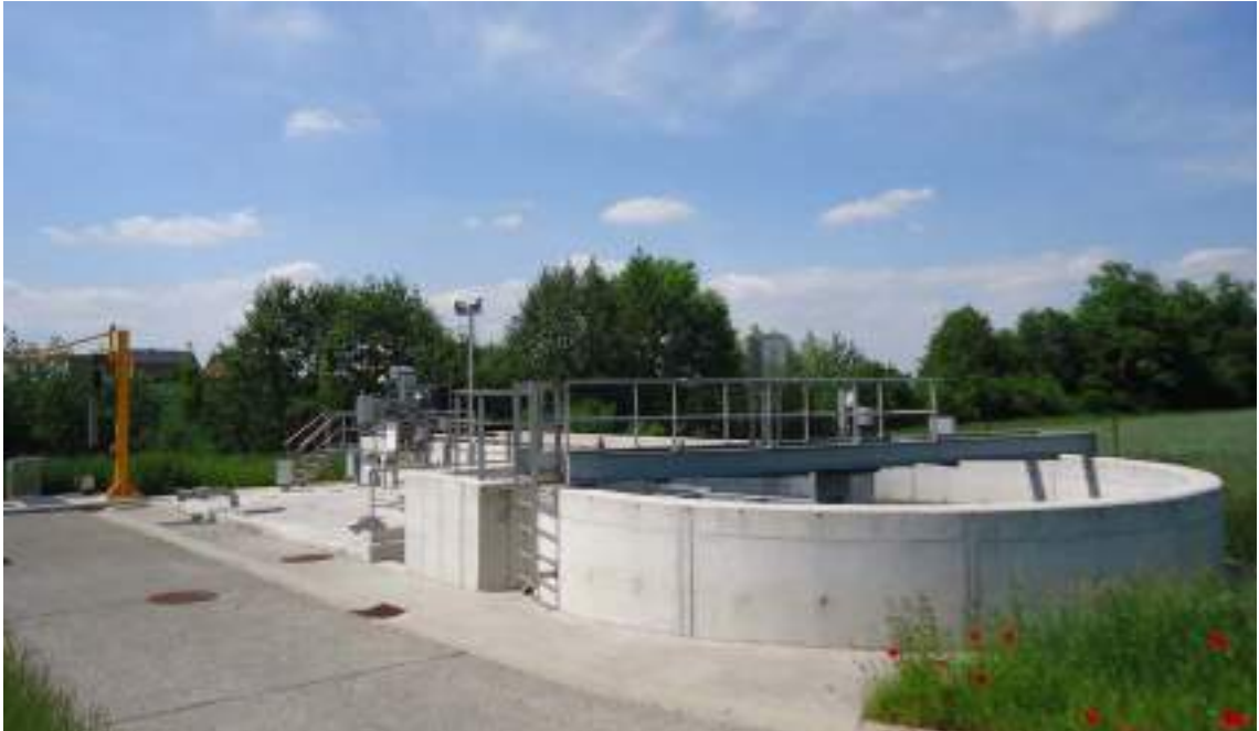
Pontillas Gochenée // Nouvelle station d'épuration
