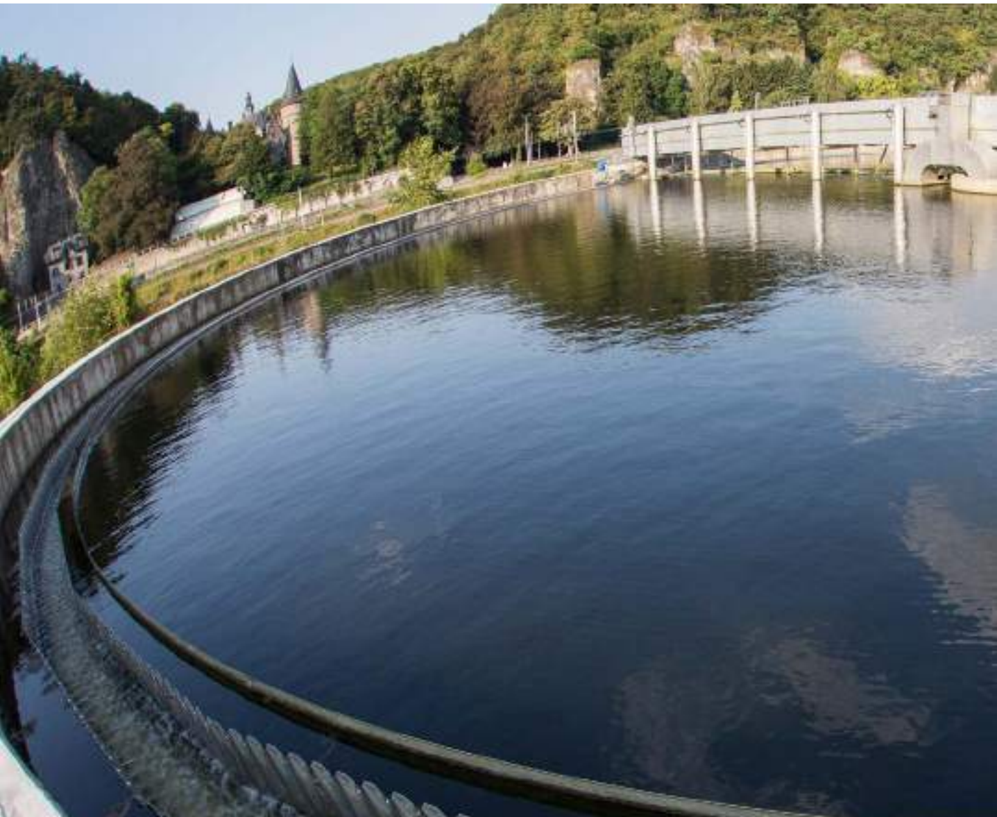
Lives-sur-Meuse // Décanteur secondaire
