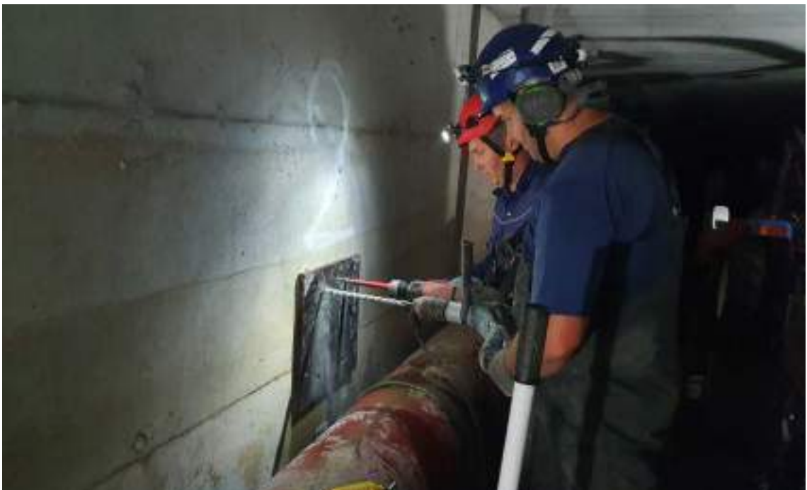
Intervention de l'équipe travaux de génie civil dans le Houyoux ruisseau canalisé
