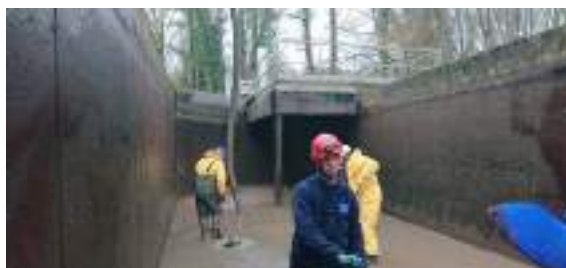
Gelbressée // Curage du bassin biologique
