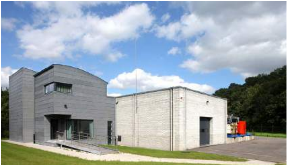
Saint-Martin // Bâtiment de la station d'épuration
