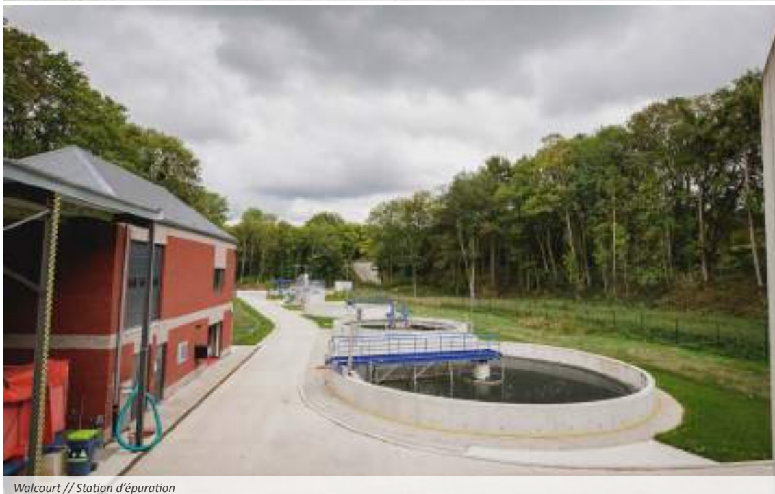
Walcourt // Station d'épuration
