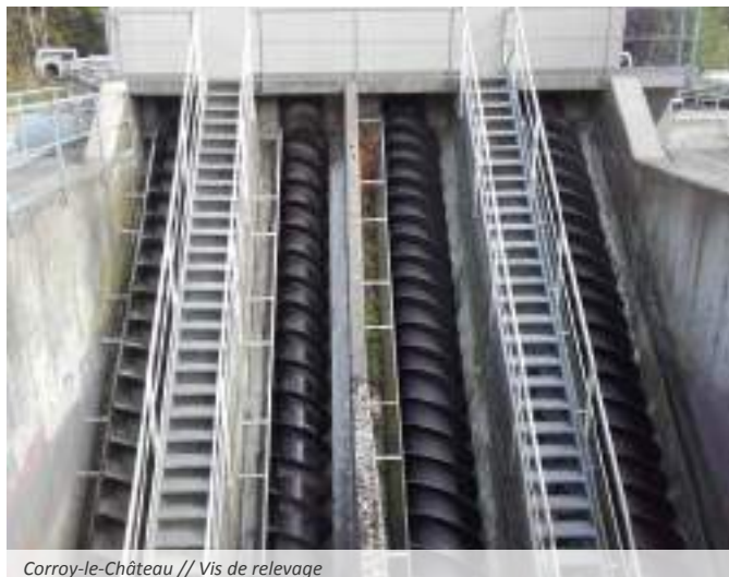
Corroy-le-Château // Vis de relevage
