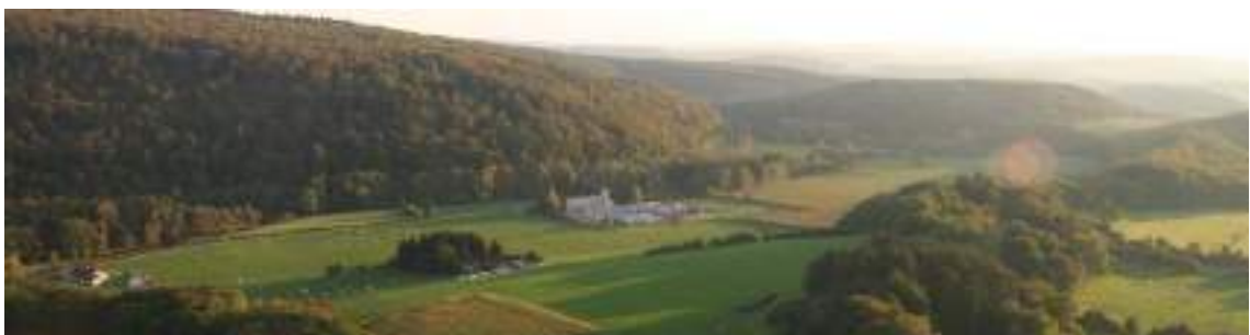
Rochefort // Vue aérienne de la station d'épuration
