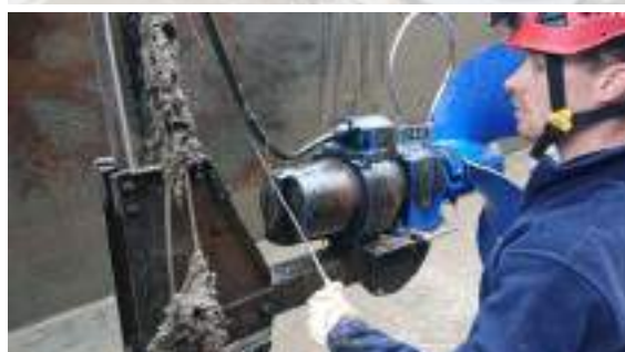
Gelbressée // Curage du bassin biologique
