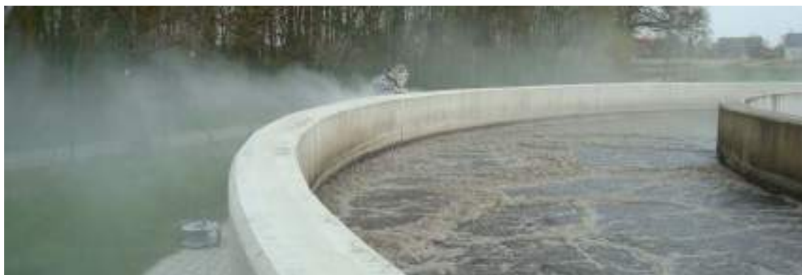
Eghezée // Réparation du chemin de roulement du pont roulant du bassin d'activation
