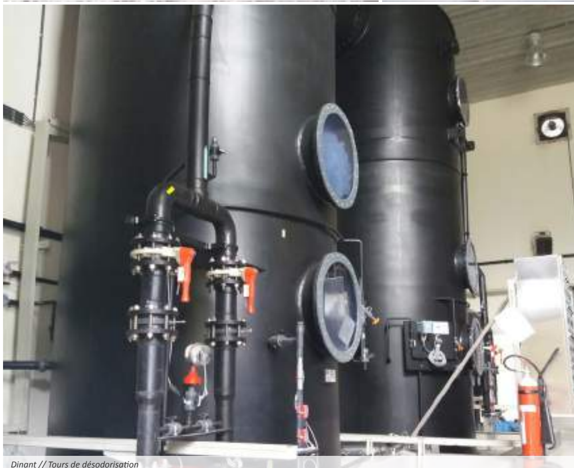
Dinant // Tours de désodorisation
