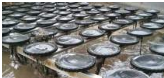
Corroy-le-Château // Intervention sur les rampes d'aération
