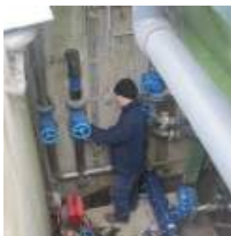
Soumy // Intervention de la maintenance sur la recirculation
