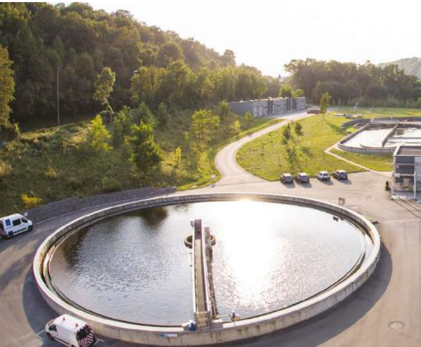
Lives-sur-Meuse // Station d'épuration
