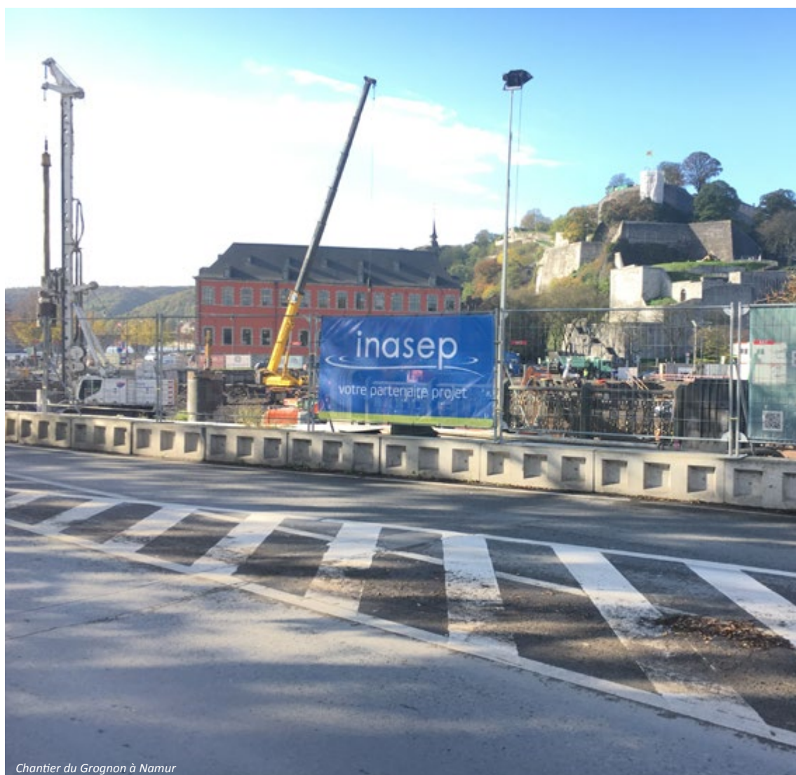
Chantier du Grognon à Namur
