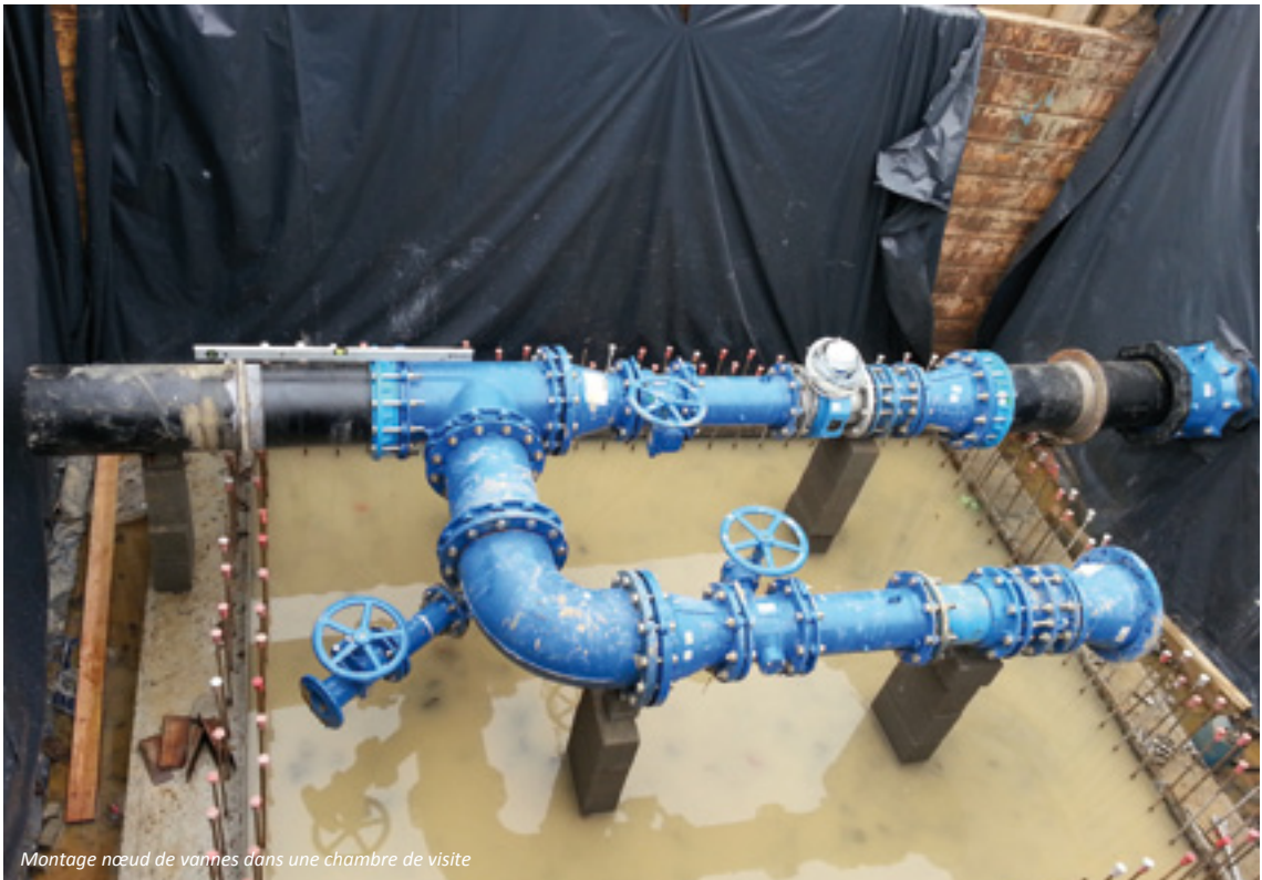
Pose conduites Fonte ductile Ø 200 vers la carrière
