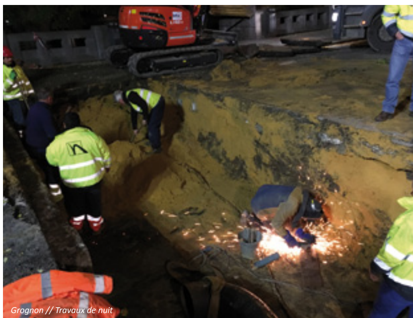
Grognon // Travaux de nuit
