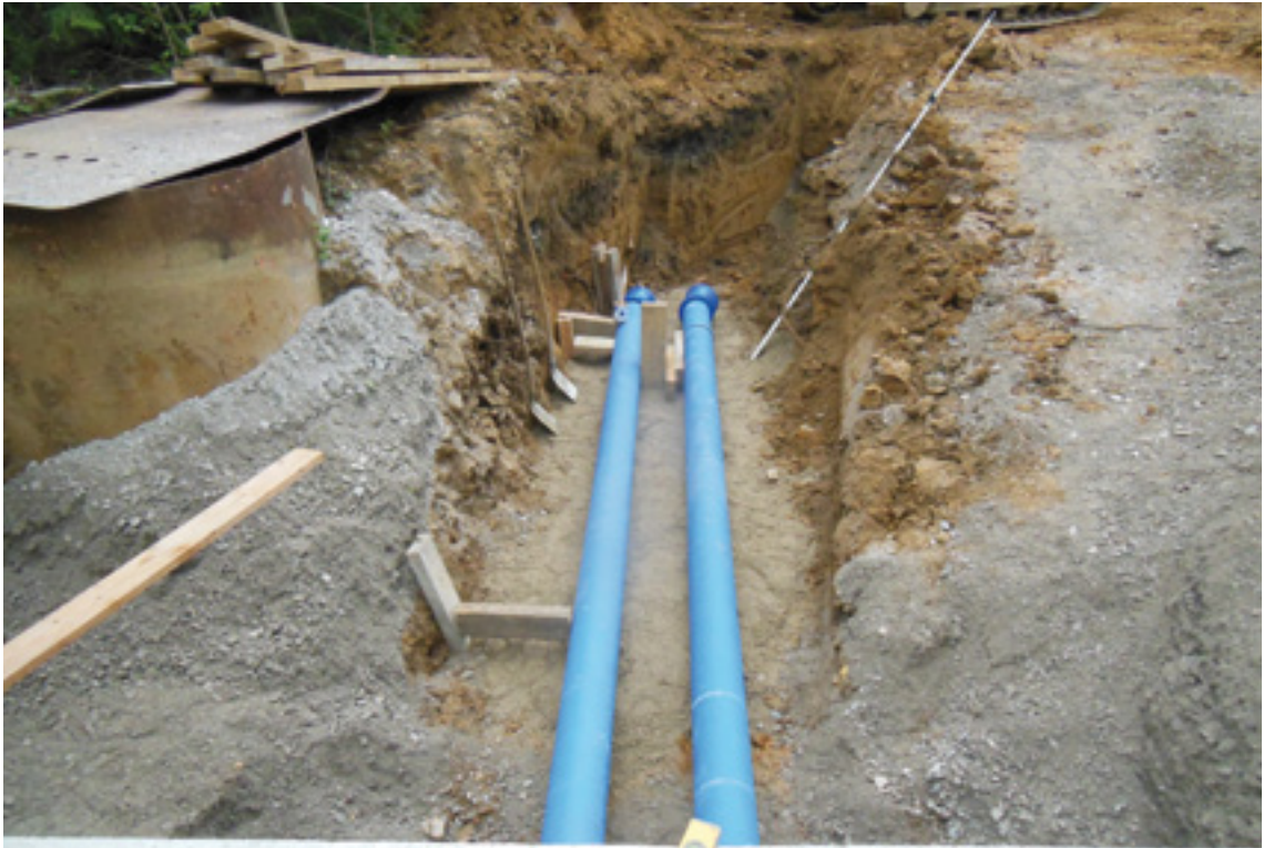
Pose conduites Fonte ductile Ø 200 vers la carrière
