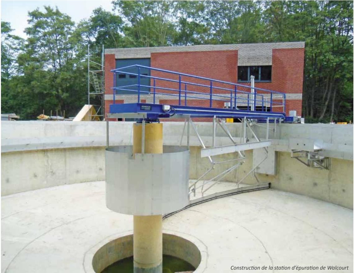
Construction de la station d'épuration de Walcourt
