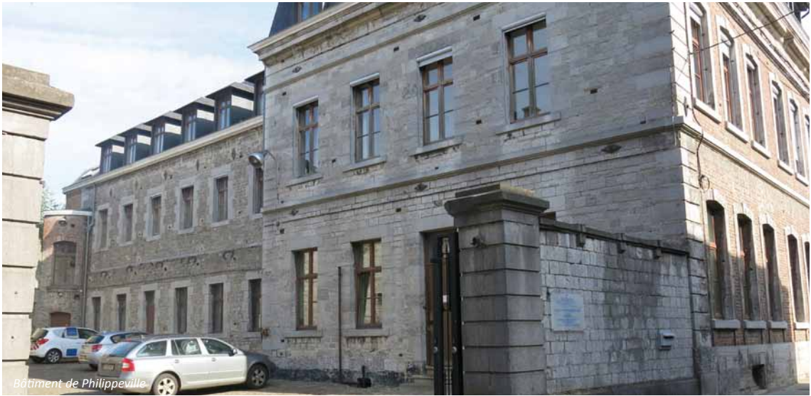
Bâtiment de Naninne
