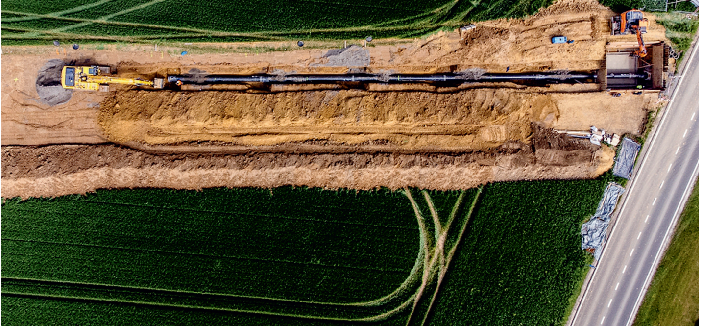
Les travaux d'ampleur n'auront finalement duré que deux ans. © EDA
